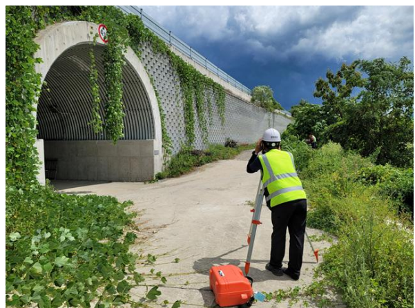
광파기를 이용한 경사도 측정
